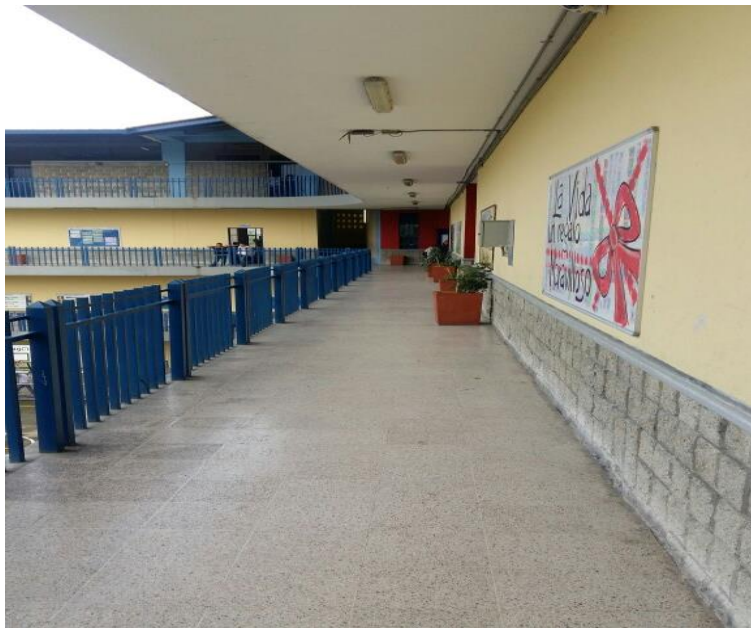
Ilustración, Corredor tercer nivel
